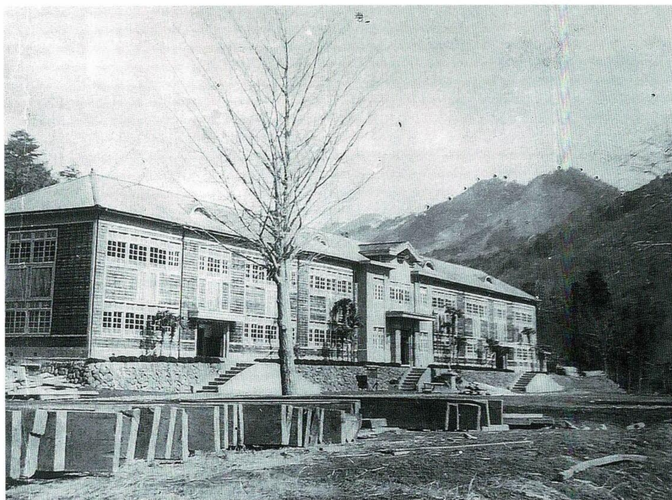
西谷国民学校表校舎全景 写真左側材料は裏校舎建設用材（岡前勇夫氏 提供）
