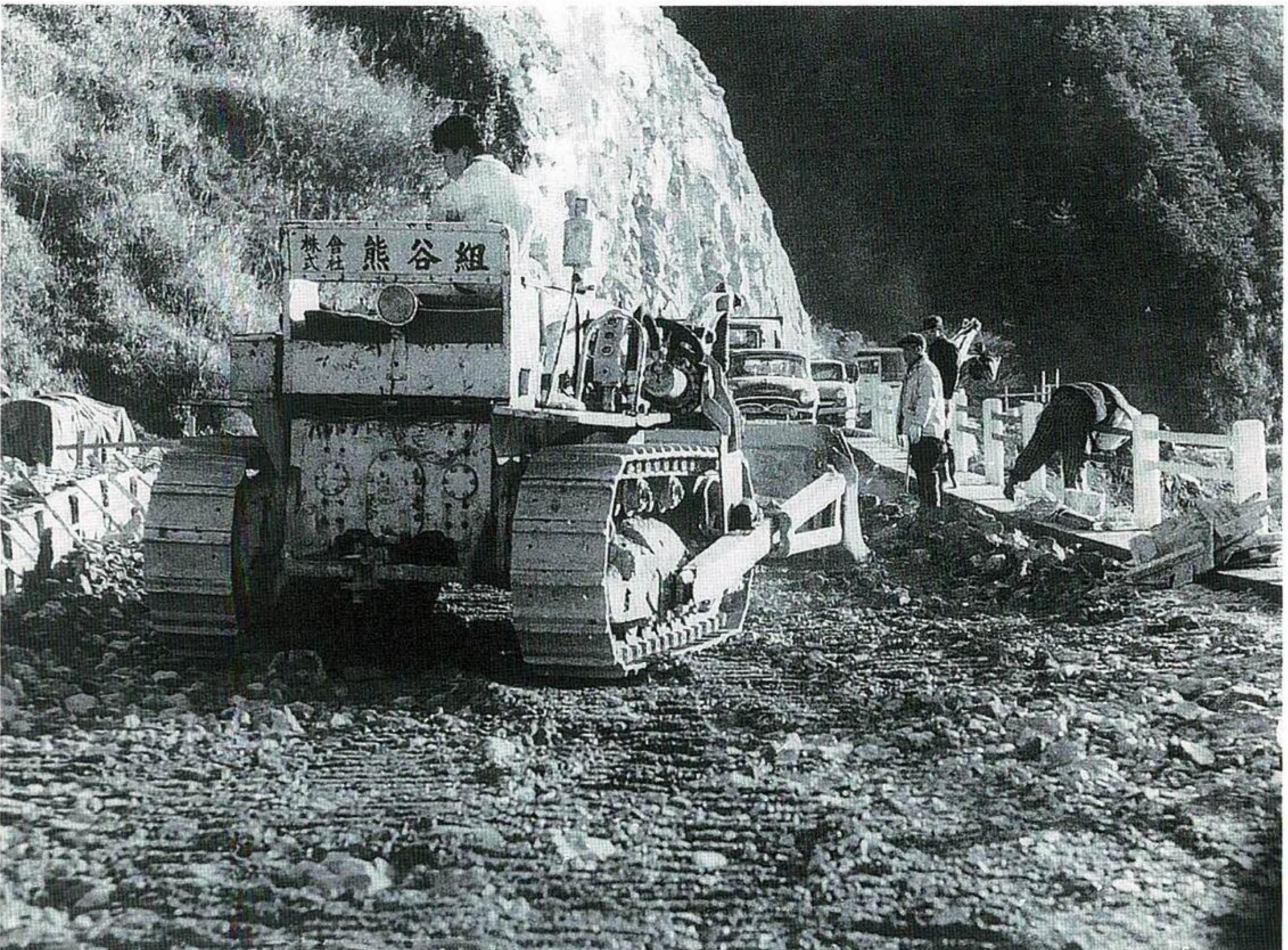
国道29号線建設工事（坂本包子氏 提供）
