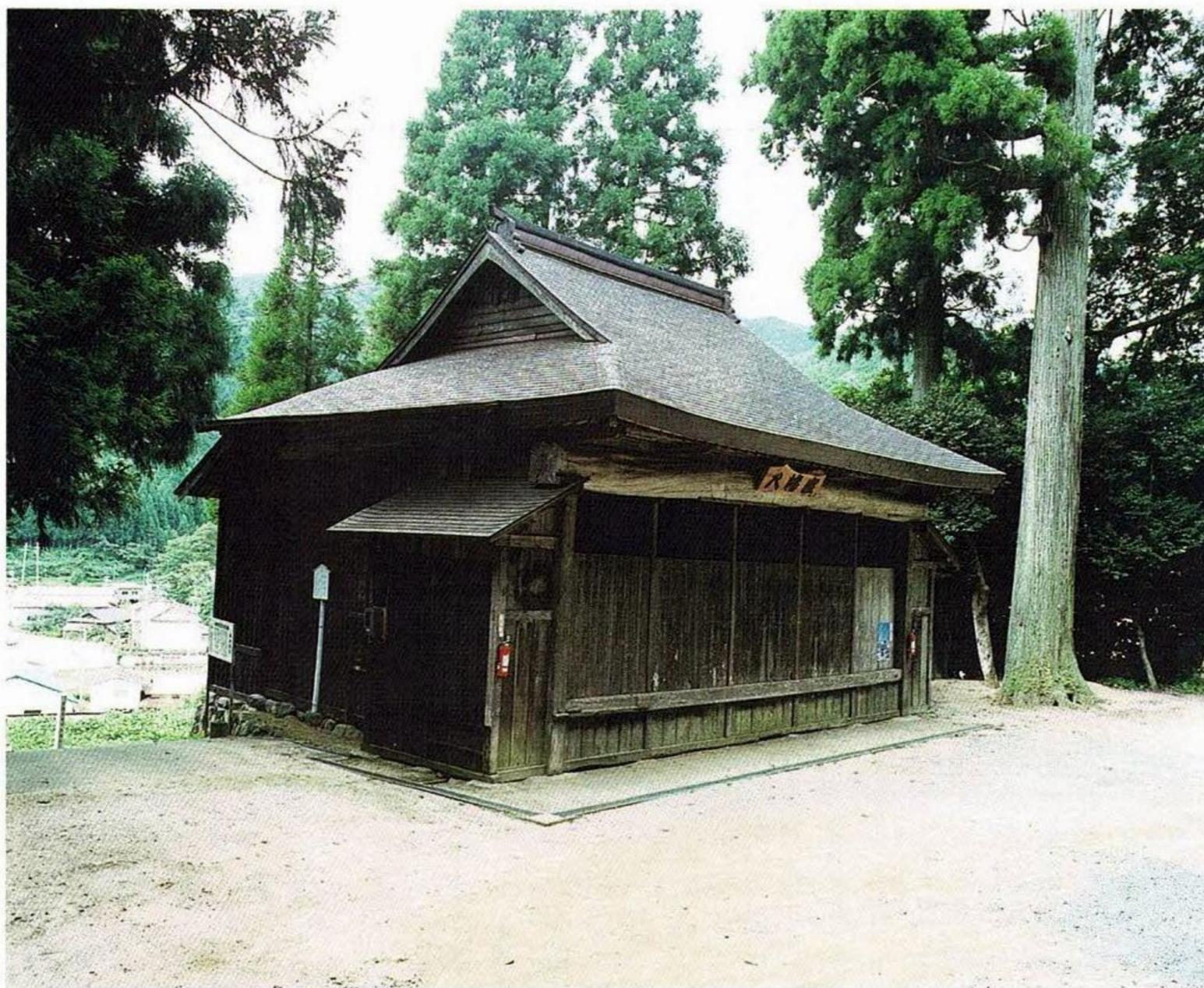
八幡神社境内にあり、明治36年（1903）の完工に成り、入母屋造り茅葺き（現在は鉄板で被覆）で、間口8間・奥行5間・床高3尺を測る。上手に太夫座、下手に高座を置き廻り舞台・二重上段両引き分け上段押し出し・反し壁など、農村の芝居堂としては優れた舞台装置を整えている。
