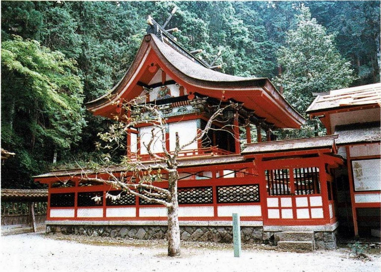
ご祭神は、葦原志許男神あしはらのし こおのかみである。高峰山（播磨風土記では黒土の志尔嵩しにだけ）より、宝亀3年（772）に現在地に遷したと伝えられている。平安朝の延喜式にも所載され、現存する本殿は3度目の火災による焼失の後、大永7年（1527）に再建されたものである。社殿は三間社流れ造りの桧皮葺きで、身舎の桁行き5.25m・梁間3.34mを測る。室町時代末期の建築様式や技法を伝える貴重な建物といえる。特に軒支輪のきしりんの工法を用いた建造物としては、極めて初期のものである。優れた宮大工によってこの技法が試された形跡があることや、彫刻には梶の葉（紙の原料木・カジノキ）が筆を巻いたものなどがあり、題材をこの地から求めたことも察せられる。ご遷座1200年に当たる昭和47年に解体修理が完成し、柱部には丹塗り、組物には極彩色が施され、建立当初の華やかな姿に復元されたものである。
